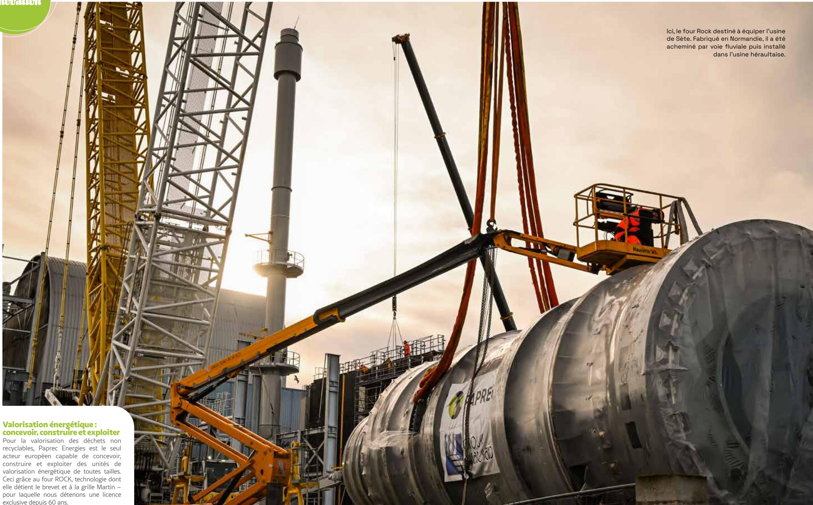
Ici, le four Rock destiné à équiper l'usine de Sète. Fabriqué en Normandie, il a été acheminé par voie fluviale puis installé dans l'usine héraultaise.
